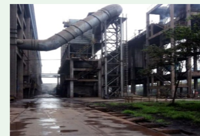
B#高炉矿槽除尘改造
