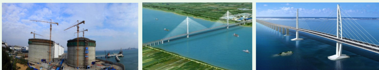
中海油福建 LNG项目
