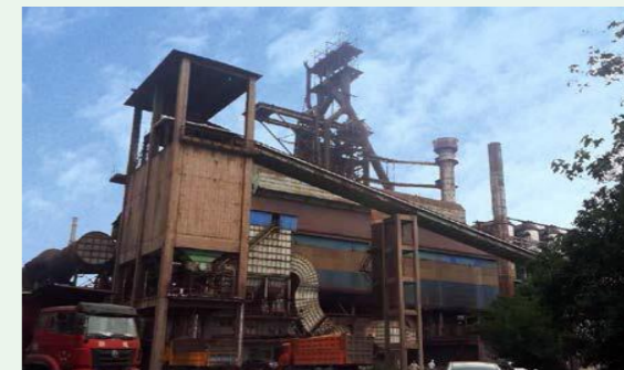
完成本部2#高炉大修改造工程
